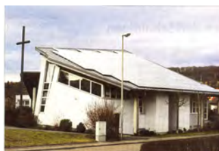
Solarstrom vom Dach des Gemeindezentrums... Das Projekt wurde im Rahmen des Franziskuspreises der Diözese Rottenburg-Stuttgart 2008 ausgezeichnet. Die Anlage wurde am 22.12.2007 in Betrieb genommen. Die Anlage speist die Gemeindezentrale der EnBW. Die Anlage hat eine Leistung von 24,80 kWp. Die Anlage wird von der Firma Solarway errichtet. Die Anlage wird von der Kirchengemeinde St. Ulrich / Maria Königin betrieben. Die Anlage wird von der Kirchengemeinde St. Ulrich / Maria Königin betrieben. Die Anlage wird von der Kirchengemeinde St. Ulrich / Maria Königin betrieben.
